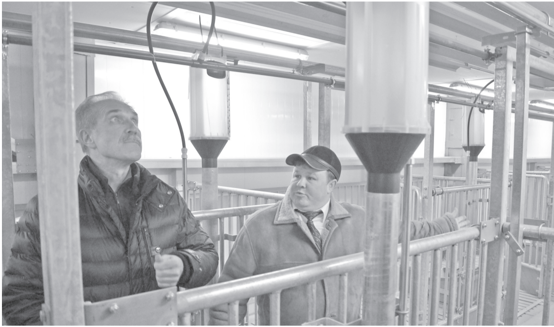
14 мая 2013 года. Губернатор Сергей Морозов осматривает новое оборудование, установленное на «МСК»
